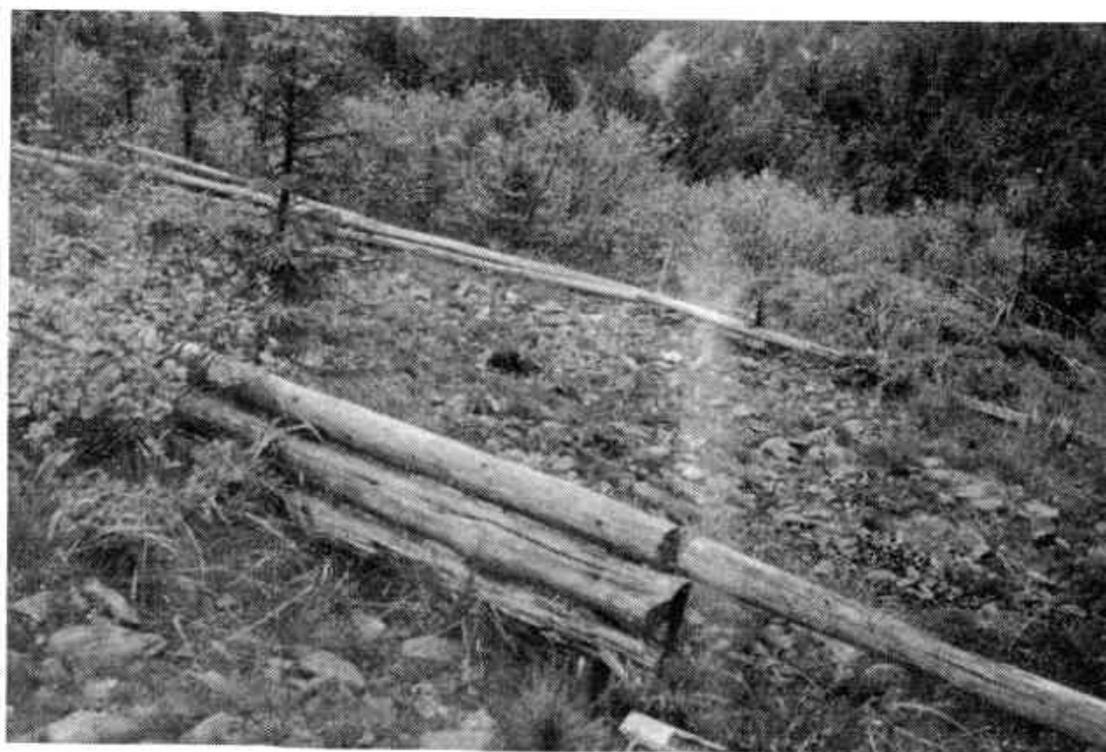
Obr. 2. Pohled do koryta strže č. 4. — ze snímku je vidět, že část strže je částečně asanována, zvláště pod dřevěnými hrádkami
