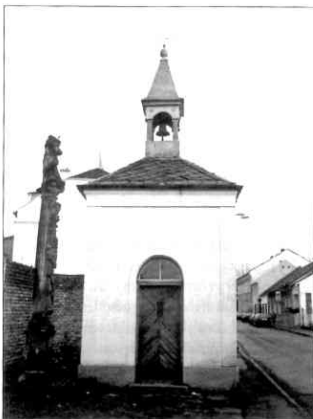
Sloup Panny Marie se zvonicí v Libušině ulici na Bělidlech. Foto autor.
