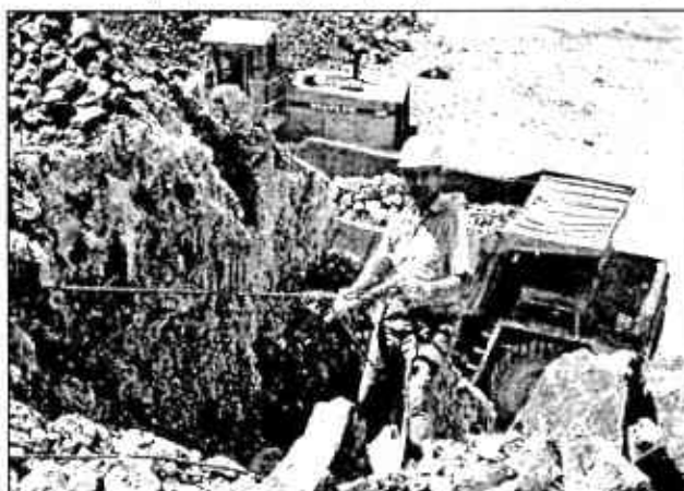
Vápenka Vitošov, lom. Způsob zajišťování dokumentace krasové zóny ve stěně mezi 2.–3. et. při těžbě. Foto: Milan Švancer, srpen r. 1999
