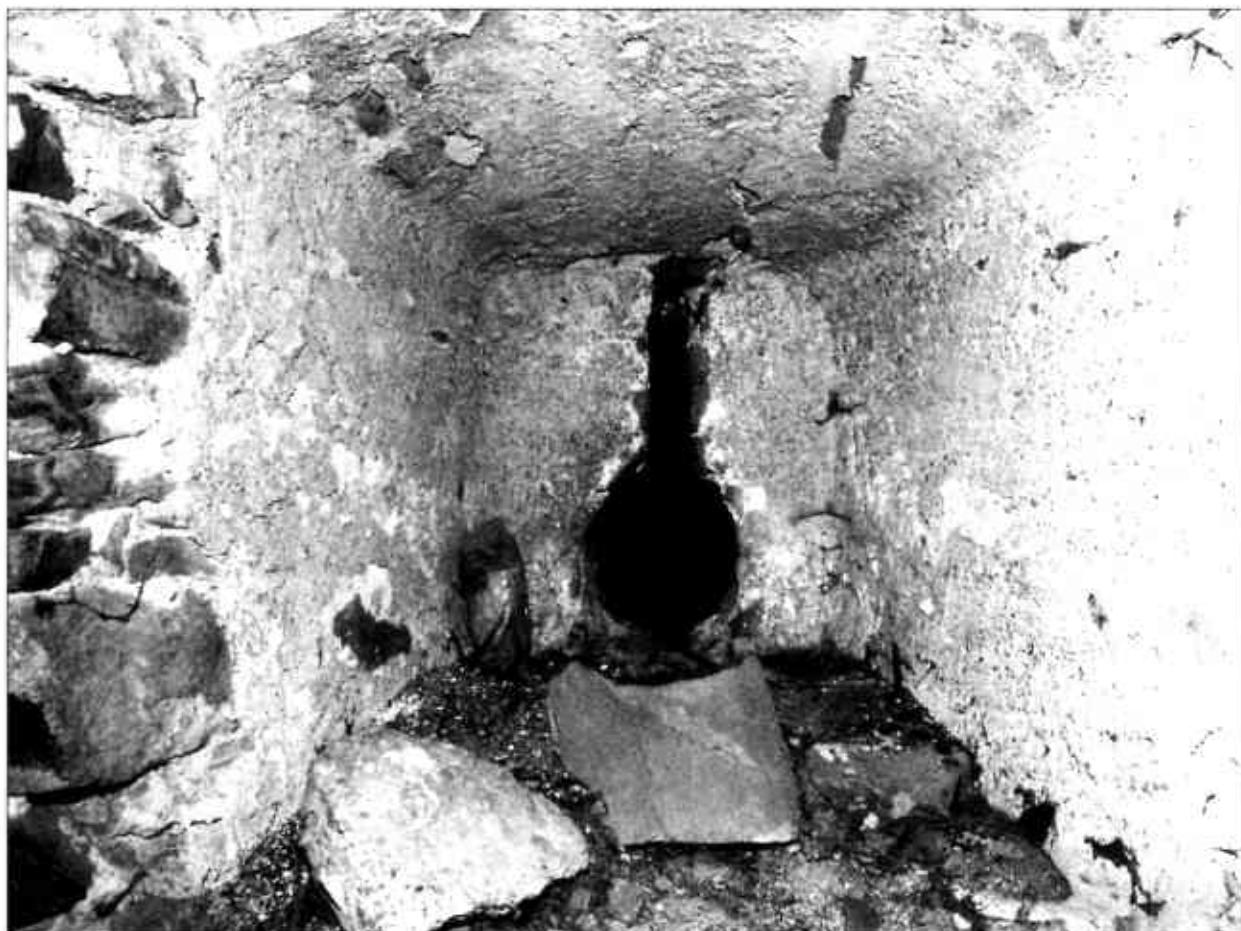
Pozdně gotická klíčová střílna v horním patře první válcové věže ve východní hradební linii.
