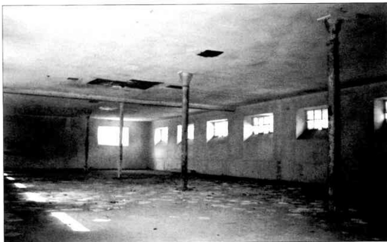
Skladovací prostor s litinovými sloupy v „Bílé továrně“. Foto: autor.
