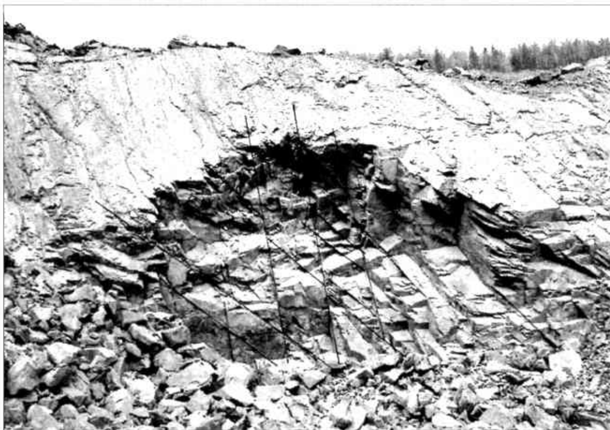
Foto 2: Kamenolom Horní Žleb, hlavní systémy příčných puklin dvojího sklonu ve výlomu stěny mezi 5. a 6. etáží (Foto: R. Morávek, květen 2008)
