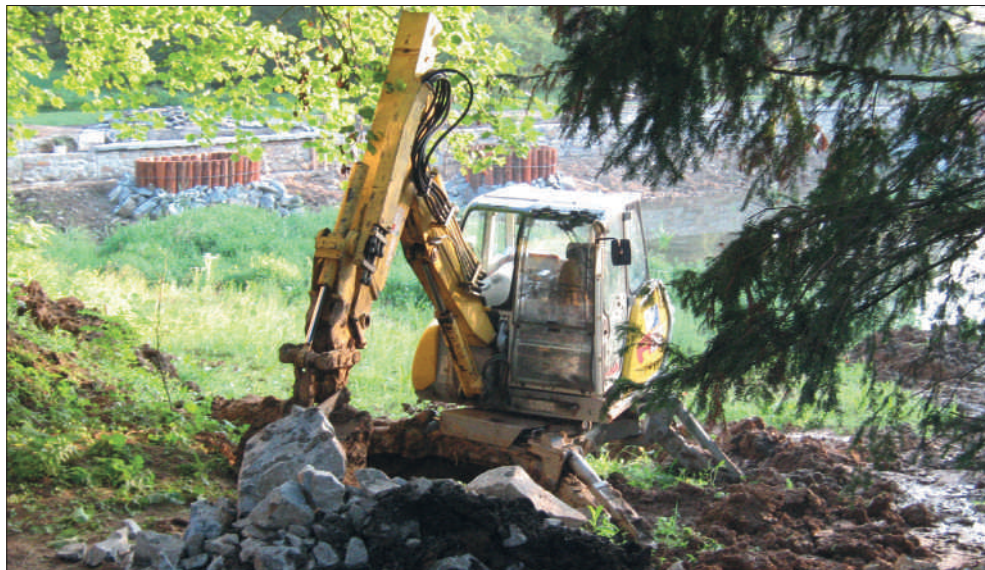
Obr. 5. Speciální bagr při vtláčování záhozu z lomového kamene do břehu.
