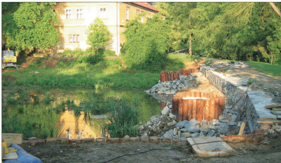
Obr. 6. Nově vymodelovaný kamenný taras na severním břehu, ostrůvky z kulatiny a břeh modelovaný pomocí srubové stěny. Foto: Jaroslav Erlec, srpen 2009
