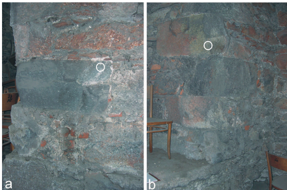
Obr. 2. a – Zdivo pravé špalety jižního okna v patře jižní věže kostela sv. Mořice. b – Zdivo pravé špalety západního okna v patře jižní věže kostela sv. Mořice. Místa odběrů studovaných vzorků jsou vyznačena kroužky. Stav v r. 2007. Foto Z. Bláhová.
