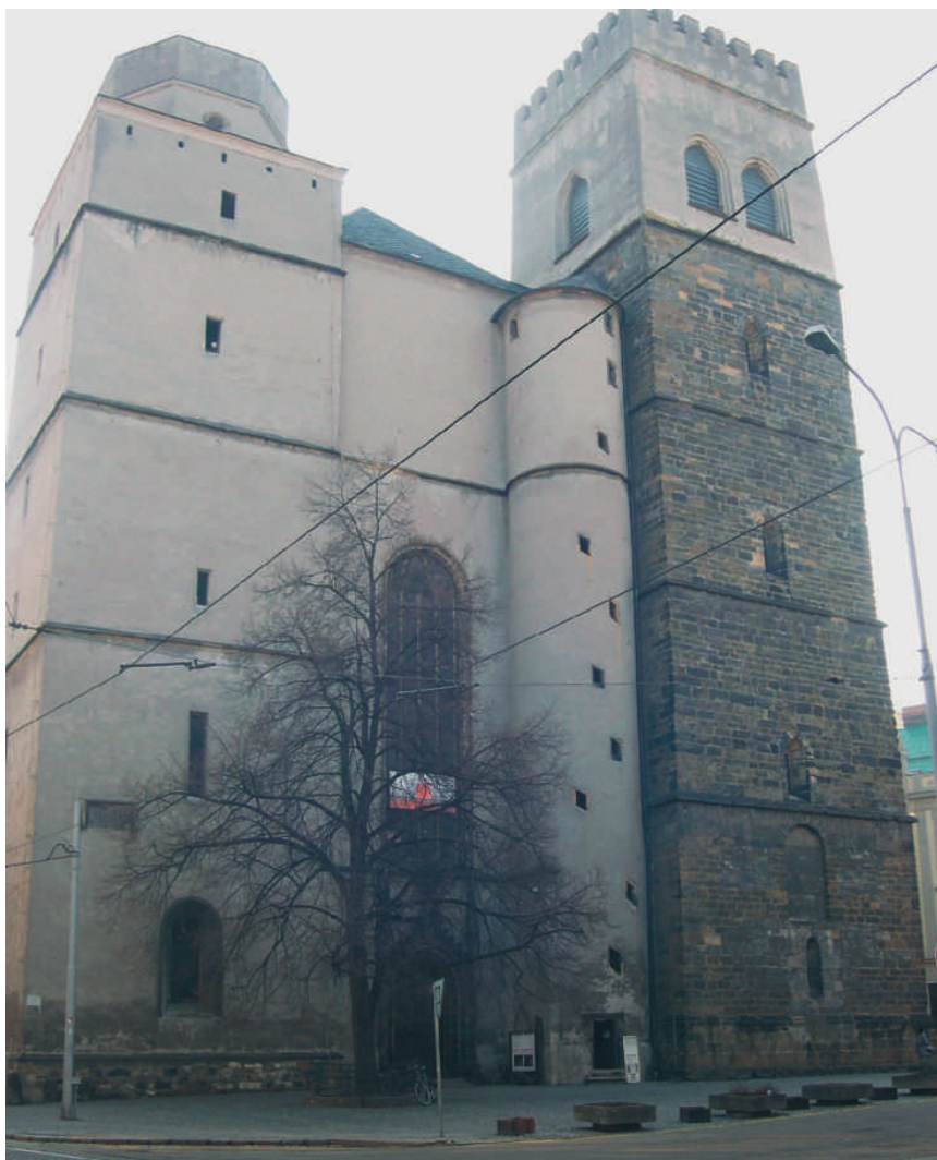
Obr. 1. Jižní (na snímku vpravo) věž kostela sv. Mořice, stav v r. 2010. Foto Z. Bláhová. Fig. 1. South tower (on the right) of the St. Mořice Church in 2010. Photo by Z. Bláhová.
